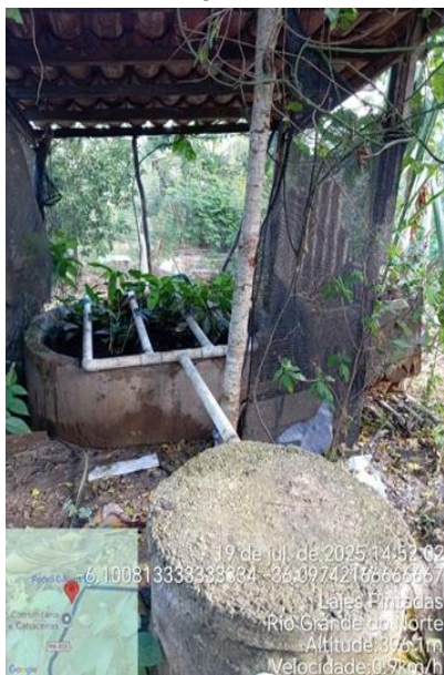
Figura 1. Sistema de tratamento básico de águas domésticas como fonte alternativa de irrigação da propriedade da família contemplada com a UTD.
