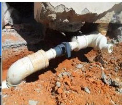
Foto3: Detalhe da válvula montada
