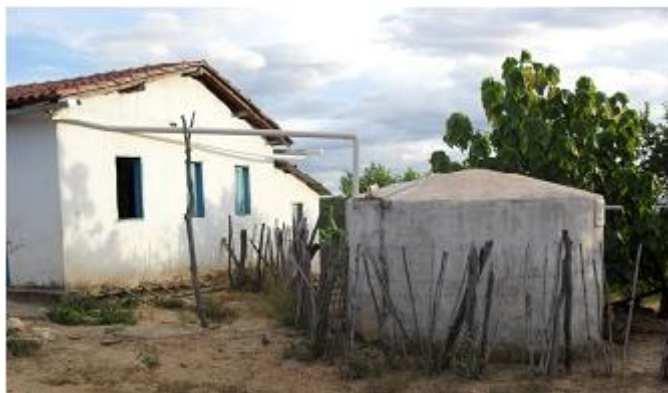
Figura 6 – Caixa de coleta da água da chuva
