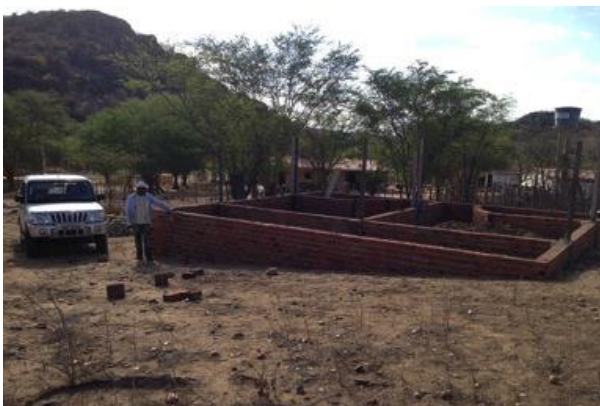
Figura 3 - Preparação das fundações da Casa com PET
