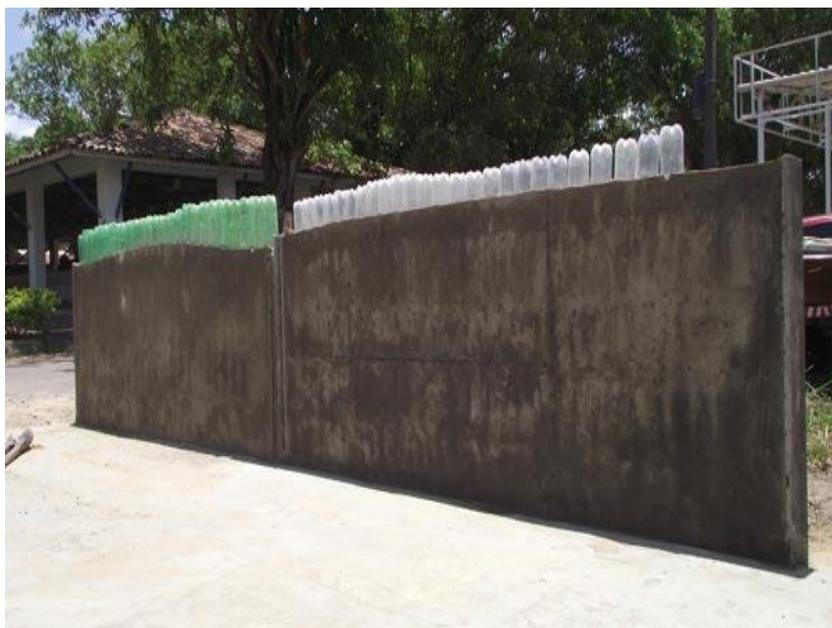
**Figura 02 - Concretagem da parede de garrafa PET. Fonte: VALE (2012)**
