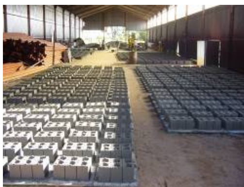
Figura 05 – Vista geral do pátio da Fábrica de Artefatos de Cimento Fonte: PROHAB, 2007
