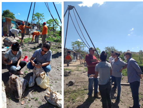
Figura 12: Registros da realização do ensaio de sondagem à percussão.
