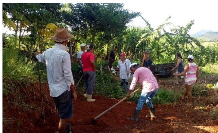
Figura 3 – Preparação do terreno para construção da farinheira
