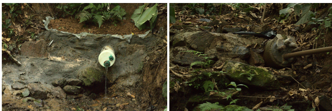
Figura 2 - Registros dos Sistemas de Proteção de Nascentes das Nascentes 1 (e) e 2 (d)
