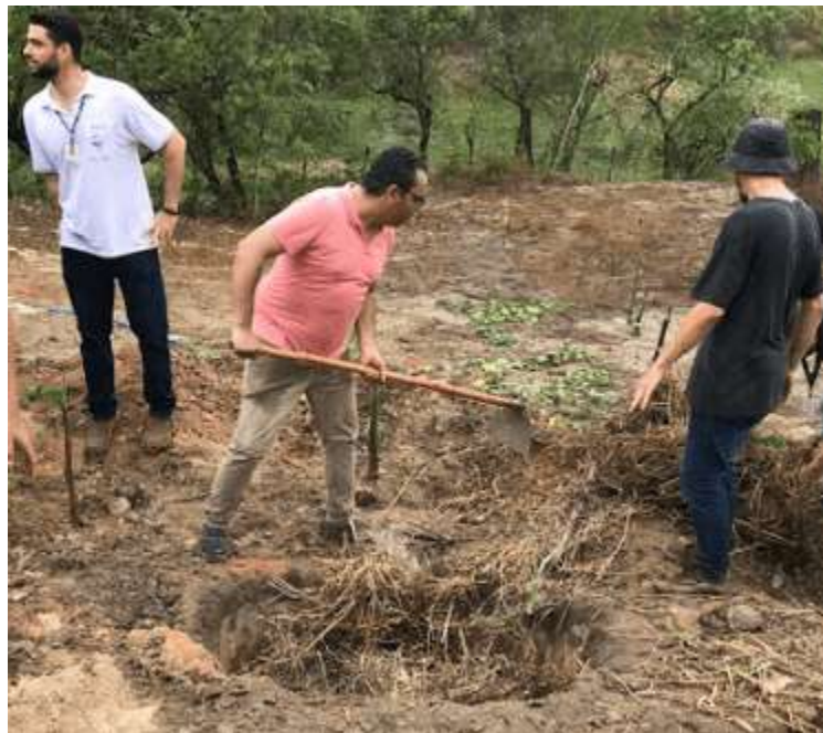
Figura 7 – Escavação e preenchimento da vala.
