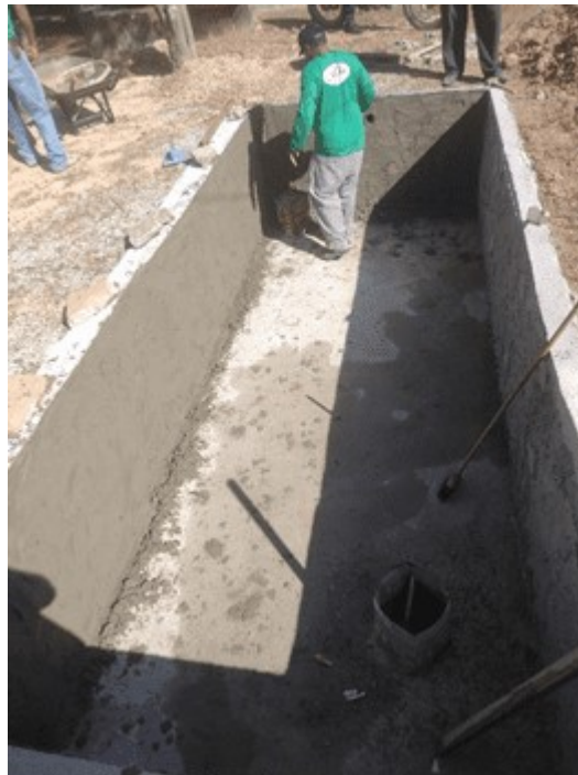
Figura 5 – Aplicação da argamassa.
