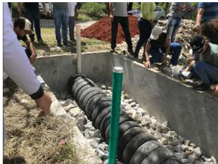
Figura 6 – Instalação da câmara interna e dos substratos filtrantes
