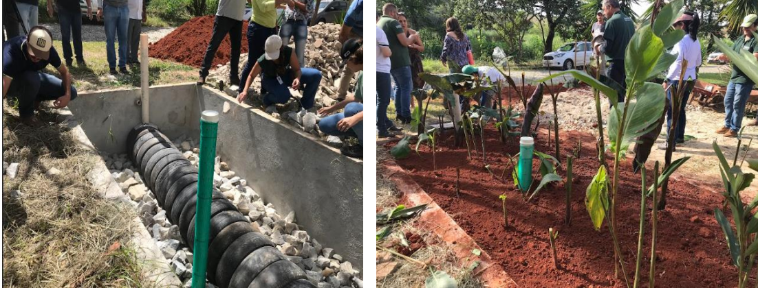
Figura 3 – Tanque de Evapotranspiração construído no Centro de Vivência em Saneamento Rural
