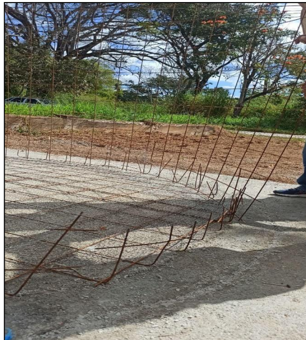
Figura 07 - Fixação da parede 2
