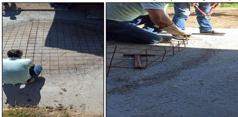
Figuras 04 e 05 - Malha de ferro e dobras do piso para fixação da parede
