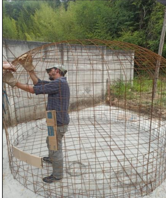
Figura 08 - Travamento do teto da estrutura
