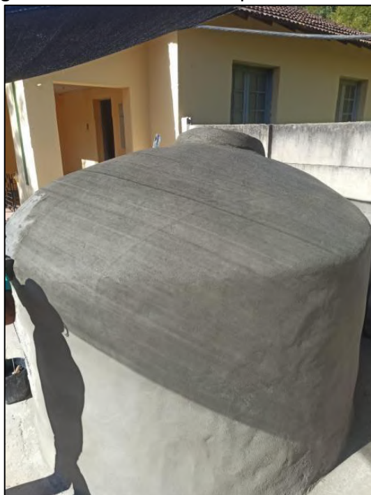
Figura 15 - Reservatório em processo de cura
