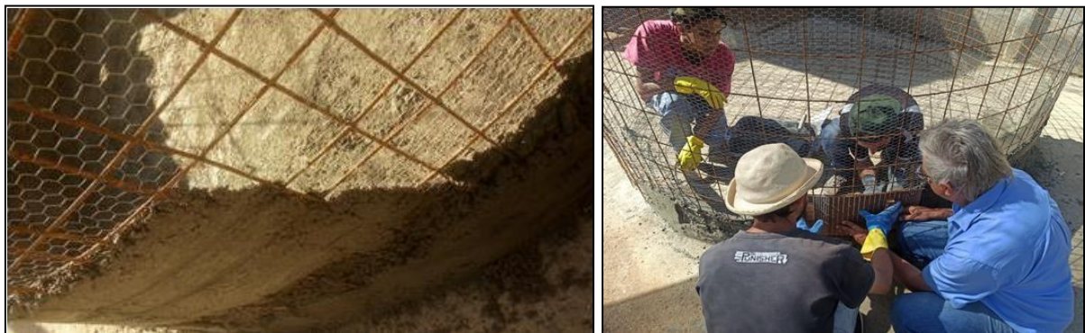
Figuras 11 e 12 - Aplicação da argamassa na parede da estrutura
