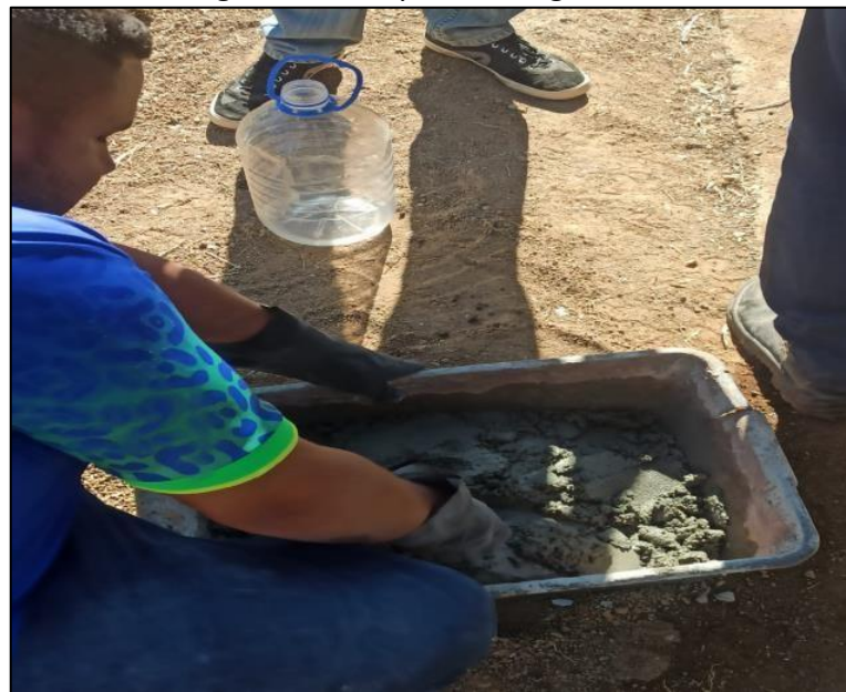
Figura 10 - Preparo da Argamassa
