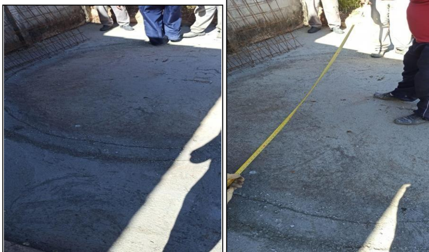
Figuras 02 e 03 - Preparação do contrapiso
