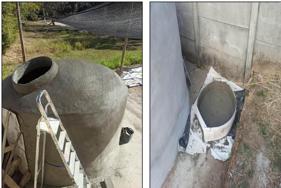
Figuras 13 e 14 – Abertura de manutenção e tampa removível da estrutura
