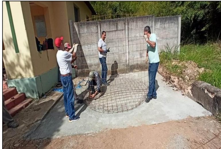
Figura 06 - Fixação da parede 1
