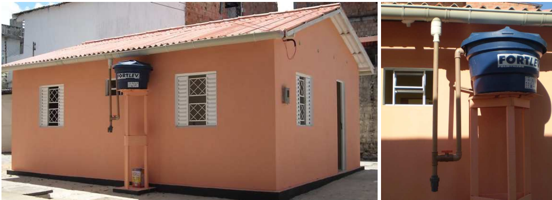
Foto 1 – Protótipo construído, na extremidade do telhado a calha para captação das águas das chuvas, ao lado detalhes da captação.
