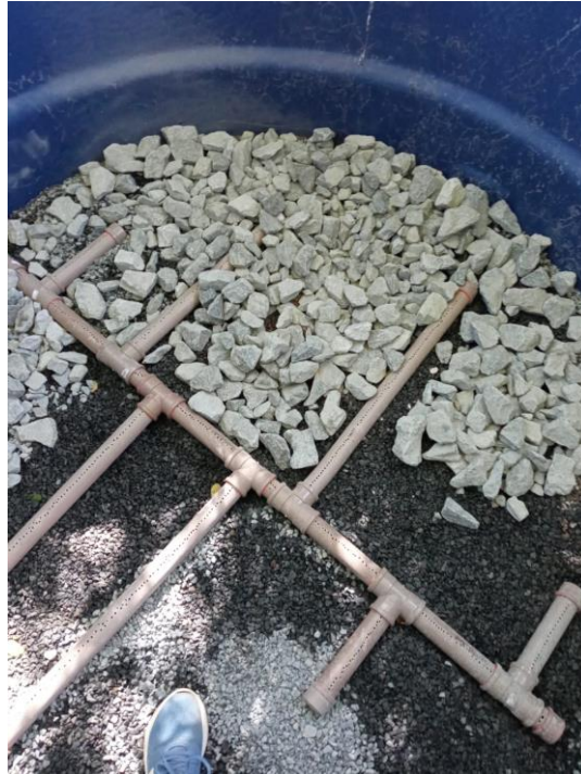
Figura 7: Manta sob a camada de brita do filtro lento
