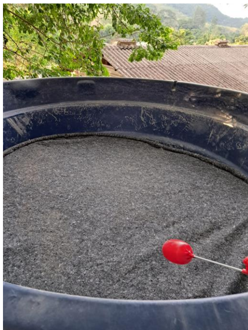
Figura 5: Manta sob o material filtrante do pré-filtro
