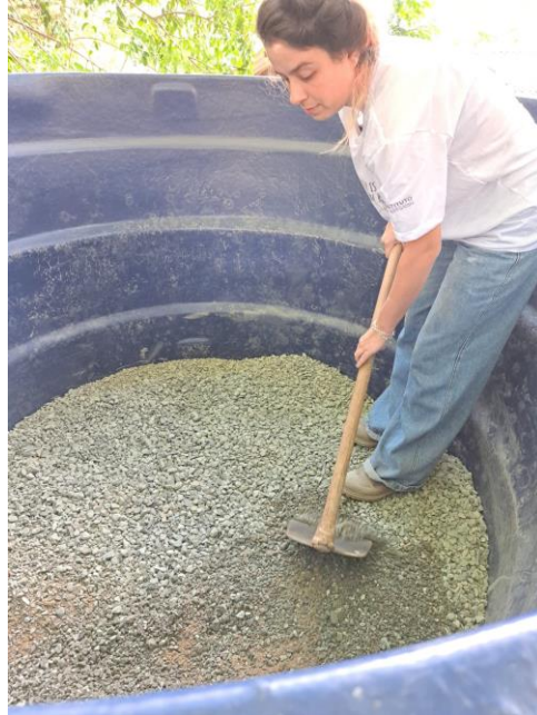
Figura 4: Camada de Brita 0 do pré-filtro
