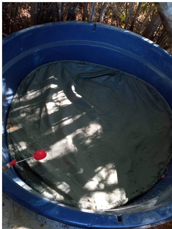
Figura 9: Manta sob a camada de areia do filtro lento
