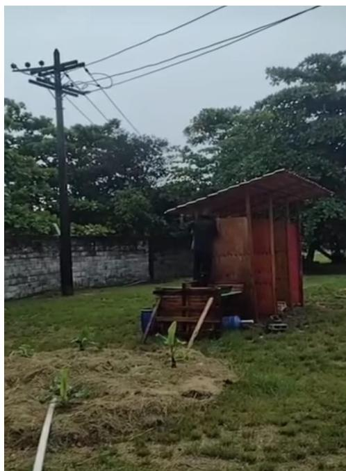
IMAGEM 01: BANHEIRO SECO DO CBA 2023 COM OS TAPUMES REAPROVEITADO E COM O SISTEMA DE SANEAMENTO APRIMORADO DO ENEDS 2022, DESTA VEZ SEPARANDO AS FEZES DO BANHEIRO SECO DA URINA DIRECIONADA AO CICLO DE BANANEIRAS PARA TRATAMENTO
