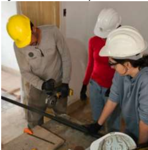
Figura 6 - Oficina de instalação de eletrodutos.
