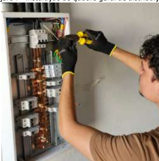
Figura 7 - Instalação do quadro geral de distribuição.
