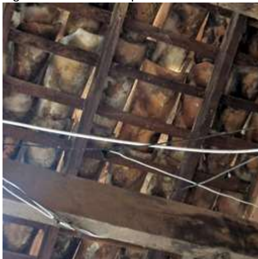
Figura 3 - Condutores aparentes com emendas.
